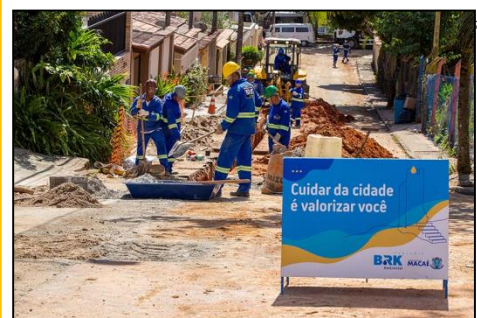
Obras para ampliação da rede de esgoto na cidade de Macaé. Localizada na Região Norte do estado do Rio de Janeiro, a cidade conheceu um acelerado crescimento nos últimos anos, associado à exploração do petróleo em seu litoral.
