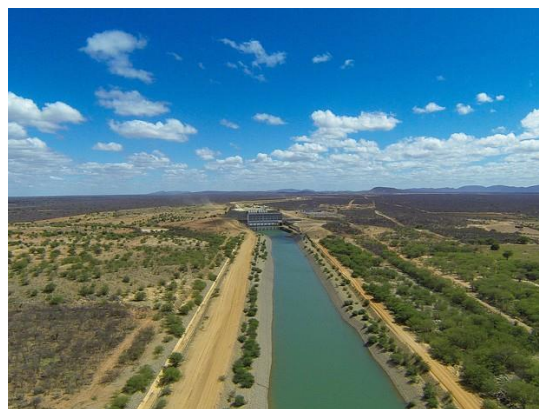
Obras no Rio São Francisco
